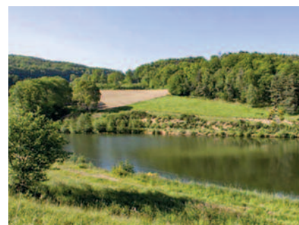
Retenue d'eau en Dordogne où cet ouvrage intégré au paysage est un atout environnemental indéniable et constitue également un attrait pour les promeneurs.
